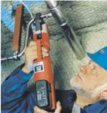
Moderne Verbindungstechniken, wie das Pressen, helfen mit, die Grenzwerte einzuhalten
