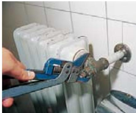
**Dann werden die Überwurfmuttern am Heizkörperventil und am Rücklauf gelöst**
