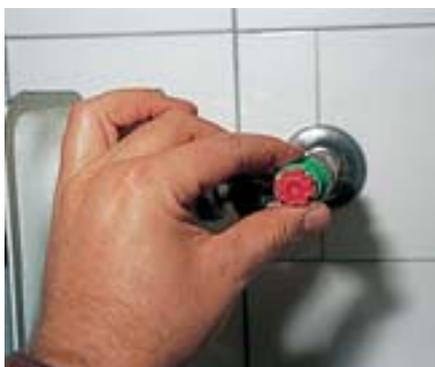
**Eine Bauschutzkappe schützt den Ventilkörper vor Beschädigung**
