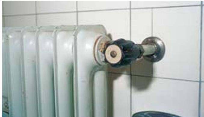
**Alte Heizkörperventile ohne thermostatische Regelung findet man noch häufig**
