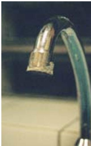
**An den Ausläufen der Entnahmearmaturen macht sich der Kalk schnell bemerkbar**
