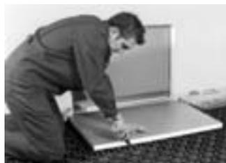
das xnet-Noppensystem ein Kombi-Set an, das eine saubere und dichte Rohrverlegung in diesen Bereichen ermöglicht. In den „Problemzonen“ wird die Noppenplatte ausgeschnitten und gegen die planebene Anschlussplatte ausgetauscht. Mit Tackernadeln werden auf dieser die Rohre befestigt.
