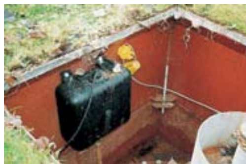
... sondern auch das Leckwarngerät (schwarz) und der Grenzwertgeber-Anschluss (gelb)
