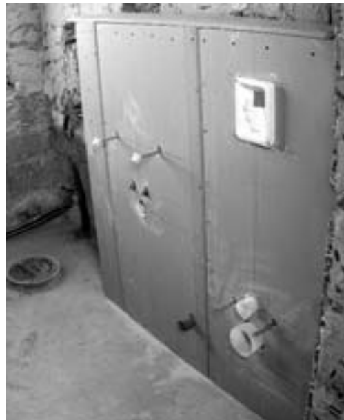
... um dem Fliesenleger eine glatte und lotrechte Oberfläche zu hinterlassen
