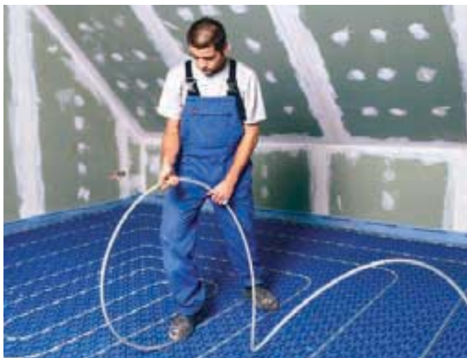
Im berechneten Verlegeabstand erfolgte dann die Rohrinstallation auf der Systemplatte
