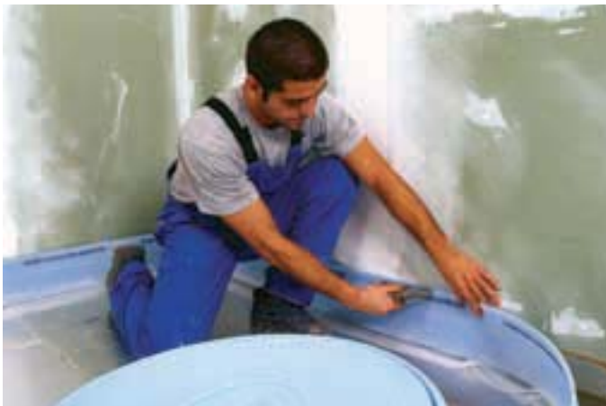
Nach Einbringen der Zusatzdämmung wurde der Randdämmstreifen angebracht ...
