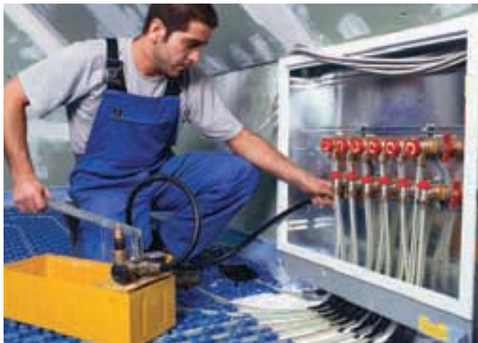
Der letzte Check: Die Anlage wird mit 6 bar „abgedrückt“
