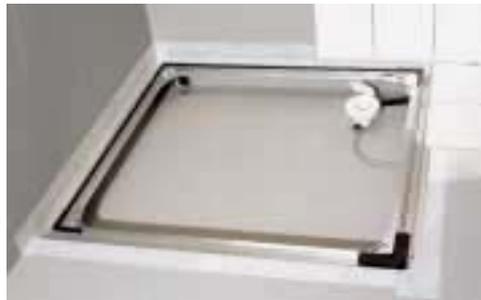
Der Einbau-System-Rahmen wird vom Fliesenleger umfließt, erst dann wird die Wanne eingebaut
