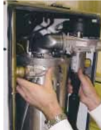
Der Wärmetauscher kann nach vorne ausgeschwenkt werden, Wasser abzulassen ist nicht nötig
