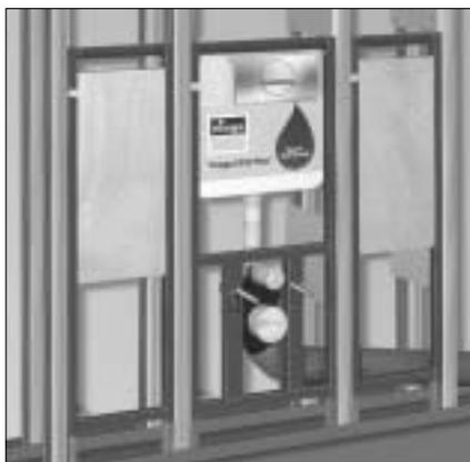
verzichtbare Zusatznutzen durch die in das Ständerwerk integrierten Holzelemente. An ihnen kann der Installateur bei Bedarf mit normgerechtem Stichmaß die Stützklappgriffe montieren. Damit ist das System Viega Eco Plus auch für einen vorausschauenden Umbau bestens geeignet.
