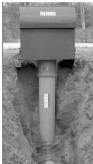
ratur des Erdreichs jahreszeitlich unabhängig etwa 10 °C beträgt, kann kontinuierlich kalte Frischluft über das erdverlegte Rohr angesaugt und so vorgewärmt werden.
