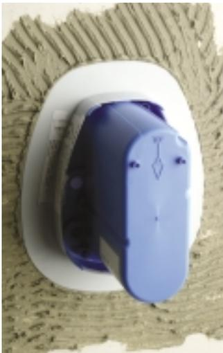
**Rund um den UP-Körper wird Fliesenkleber aufgetragen und so der Montagerahmen fixiert**
