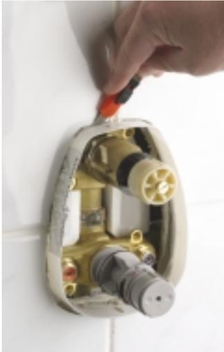
**Damit die einzelnen Bauteile des Dichtungssystems optimal ineinander greifen, muss der überstehende Dichtungsrahmen bündig zu den Fliesen abgeschnitten werden**
