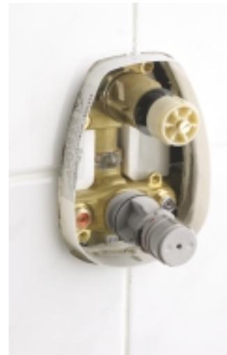
**Los geht's mit der Feininstallation: nach Abziehen der Putzschablone liegt die Technik der Armatur frei**
