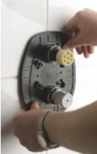
**Der Rosettenhalter wird auf den Dichtrahmen gedrückt**
