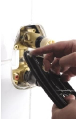
**Damit der Profildichtring des Rosettenhalters wasserdicht in den Dichtrahmen des UP-Körpers rutscht, wird der Gummiring vorher leicht eingefettet**
