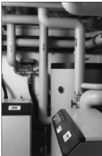
das beispielsweise mit 14 °C aus dem Boden kommt, nicht über die Wärmepumpe, sondern direkt in den Heizkreis, der dann zum Kühlkreis wird. Waterkotte liefert seine Geräte jetzt serienmäßig mit einer Regelung, die sich an heißen Tagen per Fernsteuerung auf den Kühlbetrieb umschalten lässt. Über die Kontrolle der Rücklauftemperatur wird dabei vermieden, dass es zu Taupunktunterschreitungen kommt. Diese Art der Raumkühlung ist nach Angaben von Waterkotte sehr kostengünstig,
