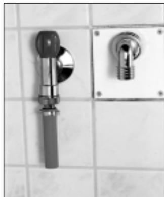
Kugelhahn ist mit Rückflussverhinderer und Rohrbelüfter ausgerüstet und so zum Anschluss eigensicherer Maschinen geeignet. Eine Schieberosette gestattet einen exakten Abschluss zur Fliesenwand.
