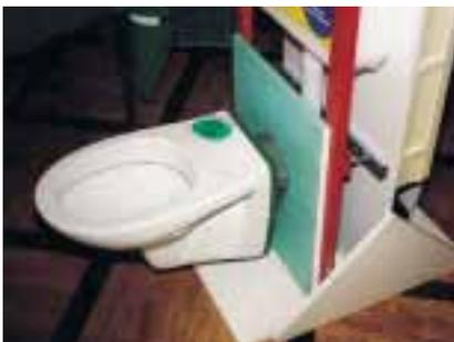
Badmodernisierung ausgeklügelt. Der Halter wird auf das WC-Trageelement montiert und bleibt mit dem WC während der gesamten Bauzeit montiert. Fliesenarbeiten können dennoch ungehindert ausgeführt werden. Der Fliesenleger fließt bis an die Kante des Bau-WC-Halters. Zur Fertigmontage entfernt der Installateur
