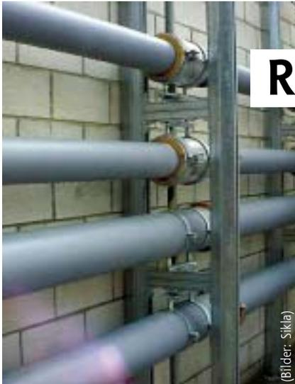
Damit sich die Rohre bewegen können, müssen spezielle Befestigungen eingebaut werden
