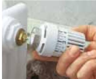
. . . und das Thermostatventil angebracht – fertig.
