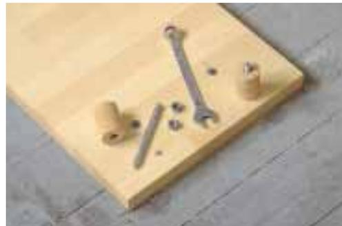
An der Leimholzplatte, die auf dem Holzboden festgeschraubt wird, werden Gewindestangen angebracht
