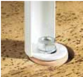
Auf den, aus dem Fertigboden herausschauenden Rundhölzern wird der Heizkörper befestigt . . .
