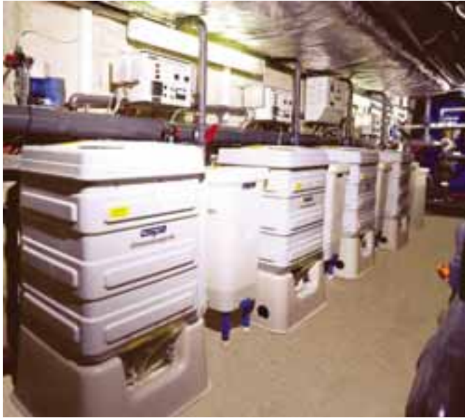
Die Chlorozonanlage produziert aus harmlosem Kochsalz das nötige Desinfektionsmittel
