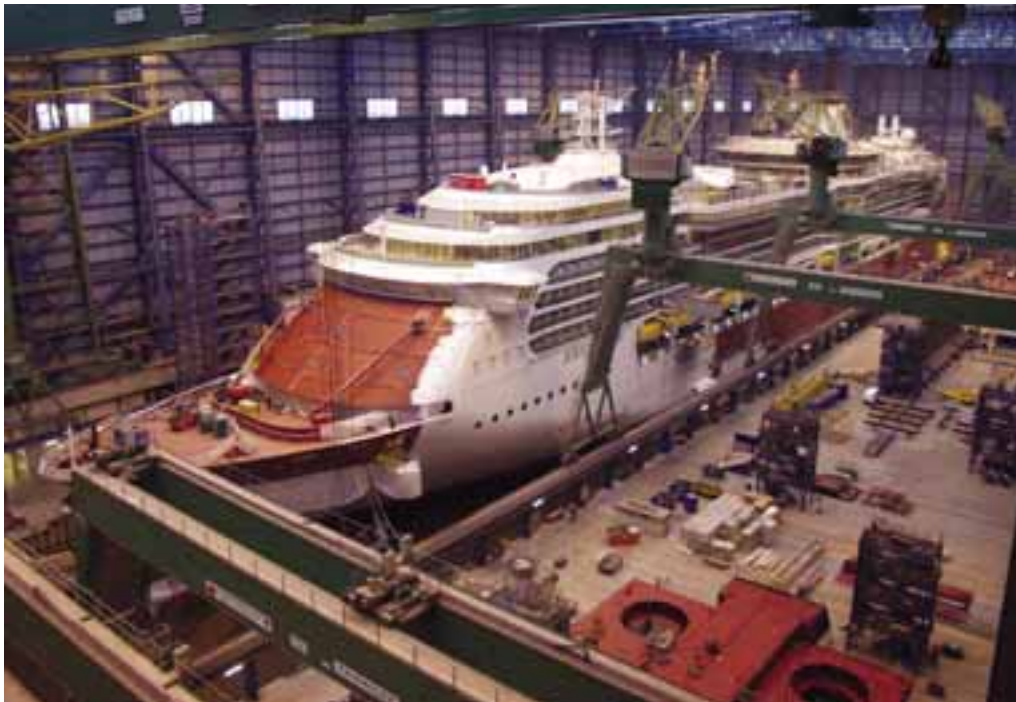
In den riesigen Baudocks der Meyer-Werft entsteht Block für Block der Rohbau des neuen Luxusliners Jewel of the Seas
