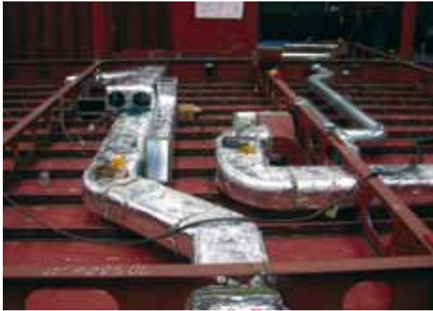
Quasi spiegelverkehrt werden die Installationen an den Decks angebracht ...
