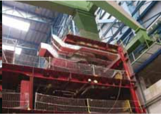
... wenn dann aus den Decks Sektionen und Blöcke entstehen, sind die Leitungen schon eingebaut
