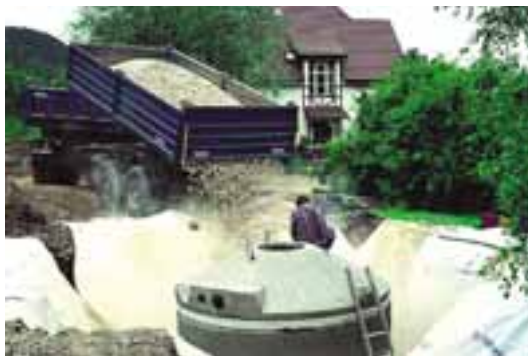
Die Kiespackung und den Geotextilmantel bekommt der Regen-Sickerspeicher vor Ort „verpasst“
