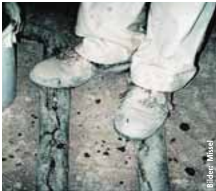
Leider gibt es auf Baustellen viele Mitstreiter, die buchstäblich auf Rohre stehen
