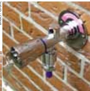
Der Einbau eines Außenwandventiles stellt die beste Lösung dar. Aber auch hier muss die Zuleitung ständig gut durchflossen sein
