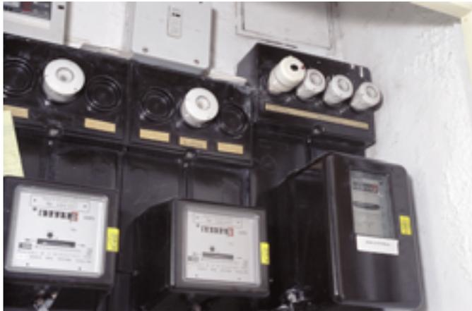
Die Sicherungen sind fast immer im Hausanschlusskasten untergebracht
