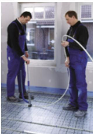
spielraum bieten und Schallbrücken verhindern. Für die drei Dimensionen 14, 16 und 17 mm des sauerstoffdichten Rohres kommt ein einheitlicher Rohrhalter und damit nur ein Werkzeug zum Einsatz. Das Rohr wird mit den Rohrhaltern direkt auf dem Element befestigt und gehalten, was die Aufbauhöhe minimiert.
