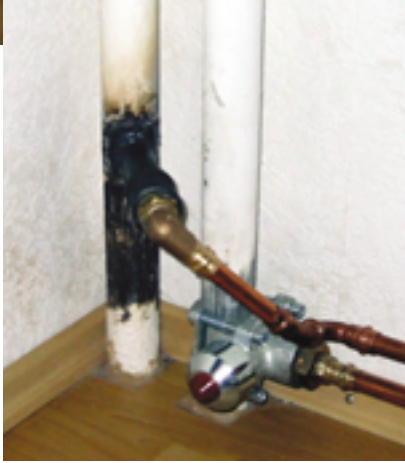
Der Rücklauf wurde durch ein Explosions-T-Stück mit der verzinkten Gasleitung (rechts) verbunden
