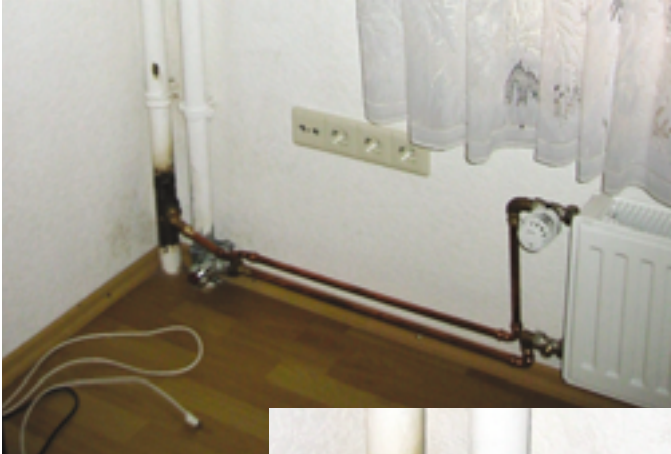
Der Rücklauf wurde durch ein Explosions-T-Stück mit der verzinkten Gasleitung (rechts) verbunden
