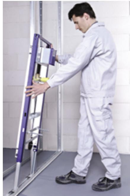
**Die Montageelemente werden in die Bodenschiene hineingestellt (6)**
