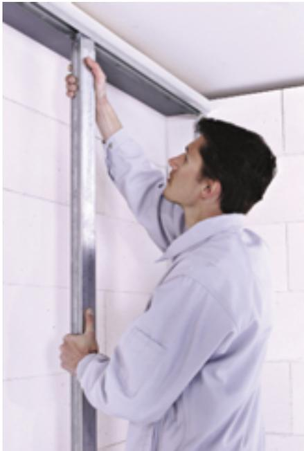
**Über eine 45°-Drehung wird der System-Ständer in die oben fixierte Schiene eingedreht... (3)**
