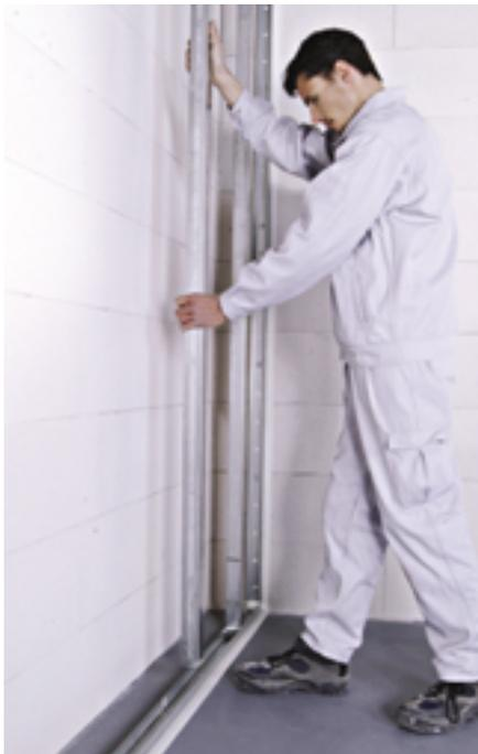
**... in die am Boden befestigte Schiene eingestellt... (4)**
