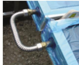
dien gebogen werden, ohne dass dadurch Querschnittsverengungen entstehen. Bei einem Biege-radius von  $2 \times$  Außendurchmesser sind Biegungen von bis zu  $180^\circ$  ausführbar. Die flexible Verbindung zwischen Gerät und Rohrsystemen eignet sich besonders, wenn Anschlüsse nach Austausch von Therme, Kessel oder Speicher wiederhergestellt werden müssen.
