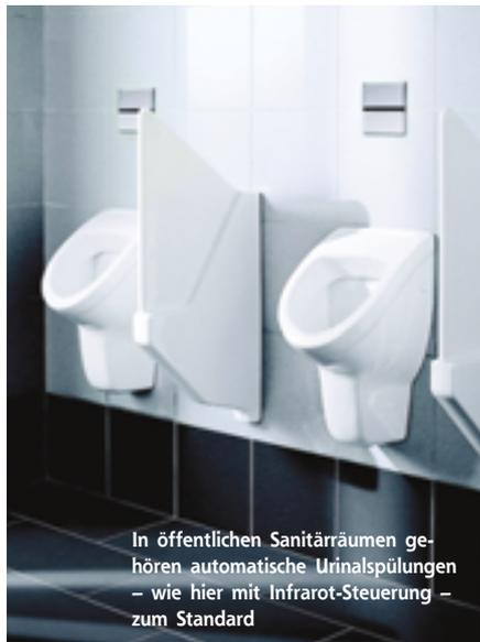
In öffentlichen Sanitärräumen gehören automatische Urinalspülungen – wie hier mit Infrarot-Steuerung – zum Standard
