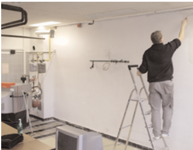
Nach Demontage der alten Anlage wurde die Wand für die neue Aufgabe vorbereitet
