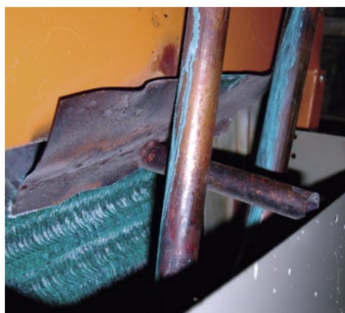
Bild 2: Sogar an eine Kondensatwanne hatte der Bastlerkönig gedacht; die Suppe lief allerdings einfach hinter den Kessel
