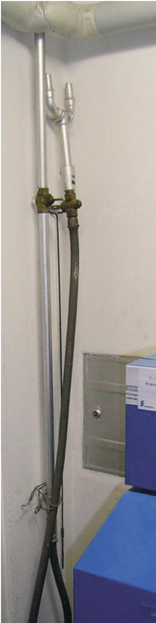
Bild 3a und 3b: Nur mittels Kegelhahn abgesperrt und ungesichert fristete dieser alte Gasanzünder jahrelang sein gefährliches Dasein
