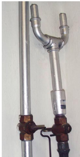
Bild 3a und 3b: Nur mittels Kegelhahn abgesperrt und ungesichert fristete dieser alte Gasanzünder jahrelang sein gefährliches Dasein
