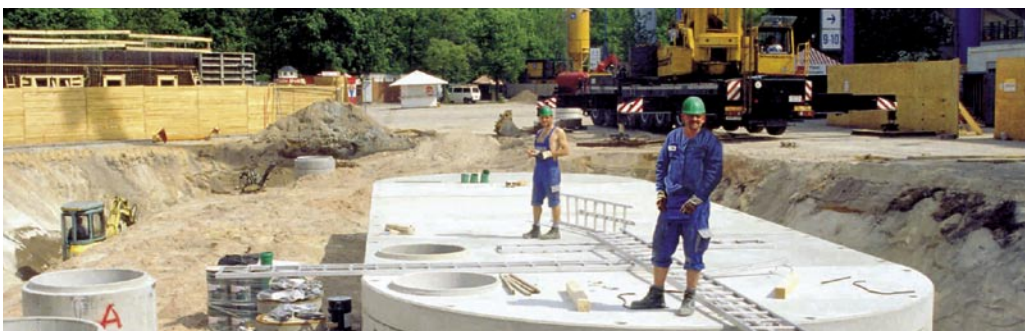
Der Speicher ist fertig: Die Bauteile wurden mittels EPDM-Dichtungen abgedichtet und miteinander verschraubt
