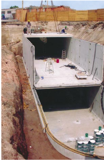
Vor dem Stadion wurden Zisternen aus Betonfertigteilen übereinander gelagert in die Erde eingelassen
