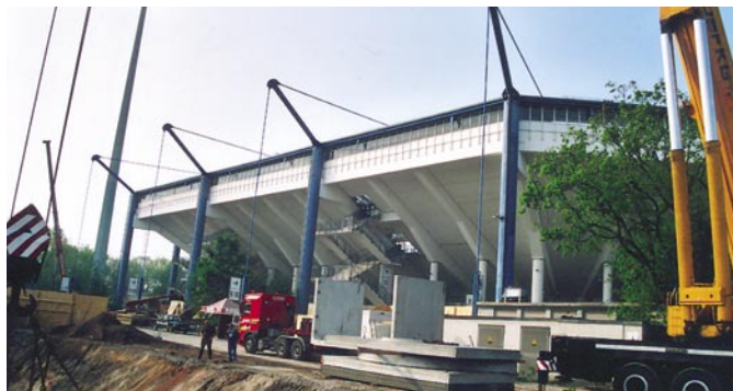
Nach Umbau der Tribünenanlage des Frankenstadions umfasst die zu entwässernde Dachfläche 34400 m 2
