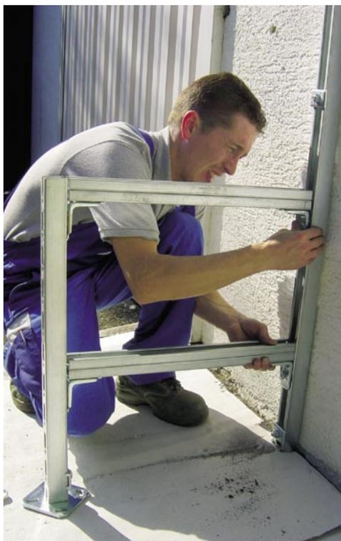
Bislang erforderte der Aufbau von Rohrhalterungen und Konsolen zahlreiche Einzelteile, ein ruhiges Händchen und viel Zeit. Mit einem neu entwickelten Befestigungssystem soll hier nun der Turbo eingeschaltet werden. Was es damit auf sich hat, erfahren Sie ab Seite 10. Bild: Sikla
