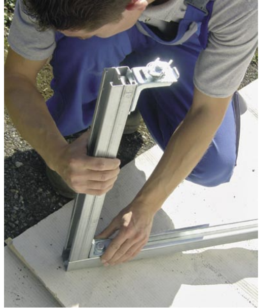
An den Winkelementen werden die weiteren Schienen ebenfalls durch Einklicken befestigt
