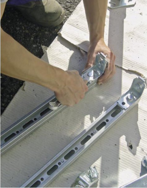
Das Winkelelement wird durch Festziehen der Schraubenmuttern fixiert
