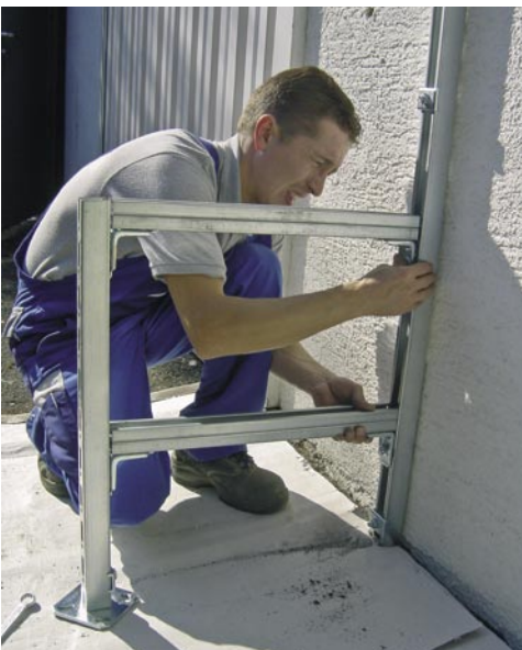
Die Konstruktion wird ausgerichtet und ebenfalls durch Anschrauben fixiert
