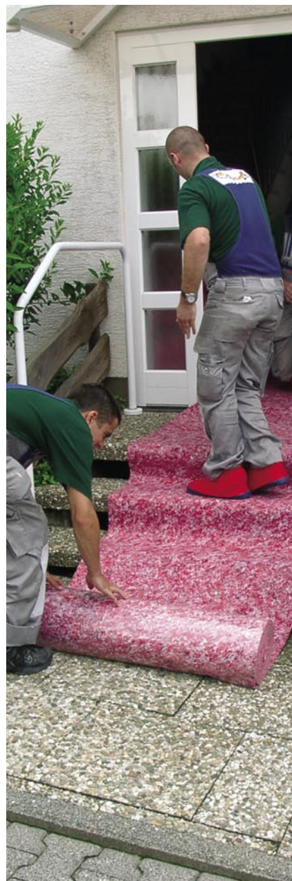
Der rote Teppich für den Monteur: Es macht Eindruck, wenn für die Durchführung größerer Arbeiten die Laufwege abgedeckt werden
