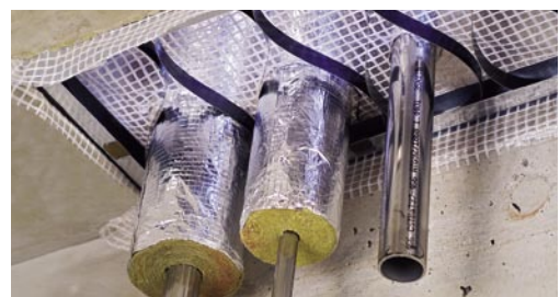
Leichte Übung für den Installateur: Ein Gitternetz aus Kunststoff wird in der Deckenaussparung montiert und die Rohre hier durchgeführt
