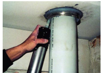
Brandschutzkitt kann meistens – wie Silikon – aus einer Kartusche verarbeitet werden
