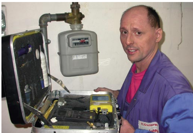
Das Leckmengenmessgerät liefert mit der Leckrate nur ein Indiz – die Bewertung ist Sache des Profis
