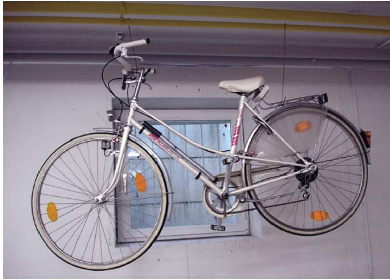
Auch solcher Missbrauch stellt die Gebrauchsfähigkeit der Gasleitung in Frage
