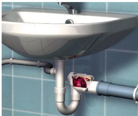
Ablaufstellen, die unter der Rückstauenebene des Kanalsystems liegen, müssen gegen Abwasseraustritt bei Rückstau gesichert sein. Bei der Entwässerung einzelner Sanitäröbjekte kann das direkt am Geruchverschluss geschehen. Welche Möglichkeiten es sonst noch gibt und was dabei beachtet werden muss, lesen Sie ab Seite 6.
