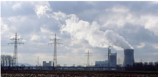
Der Stromtransport erfolgt in den Überlandleitungen mit Spannungen von bis zu 400 000 Volt. Mit der hohen Stromspannung erreicht man, dass sich die Transportverluste in vertretbaren Grenzen halten
