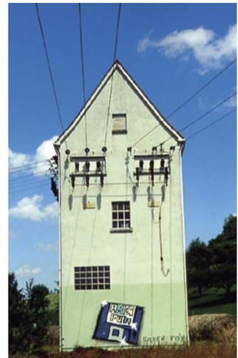
Im Trafoshaus wird die Hochspannung dann wieder zu braven 400/230 V heruntertransformiert
