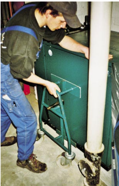
Das Bewegen des Dachs erfolgte mit einer Transporthilfe
