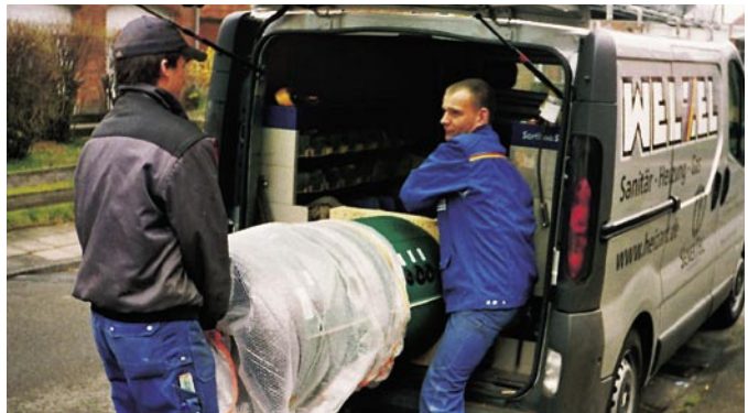
Ein Kraftakt bei der Montage war die Aufstellung des Warmwasserspeichers
