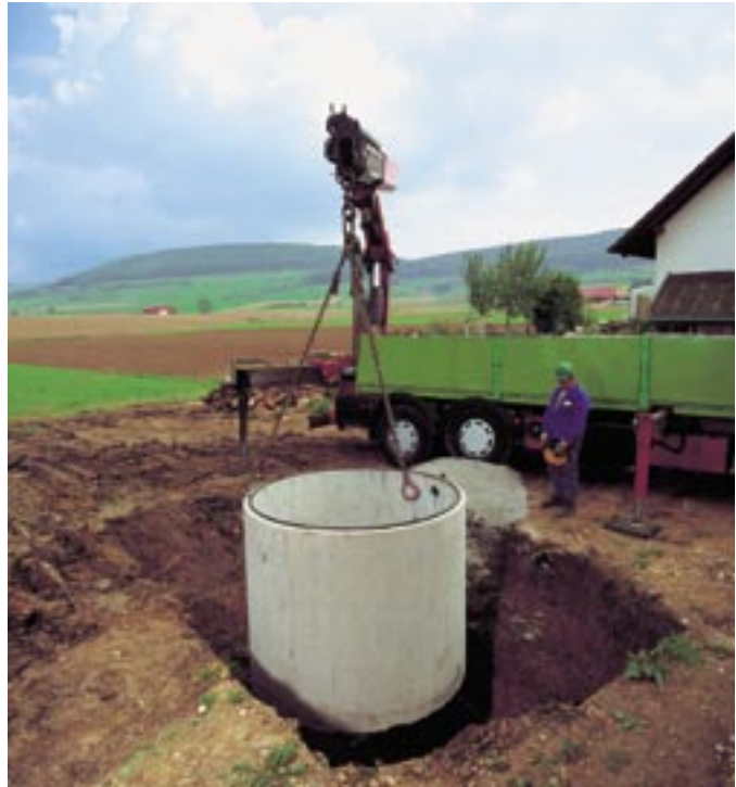
Der Pelletspeicher wird direkt vom LKW in die Baugrube gehoben und auf einer 15 cm dicken Sandschicht gesetzt
