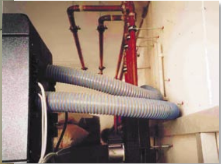
Saugschlauch und Rückluftschlauch sind für eine staubfreie „Fütterung“ des Heizkessels nötig
