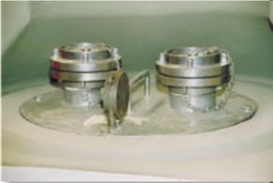
Zum Befüllen per LKW wird der Druckschlauch und die Rückluft an die Kupplungen im Speicher angeschlossen
