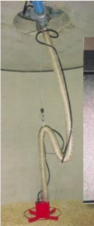
Saugschlauch und Rückluftschlauch sind für eine staubfreie „Fütterung“ des Heizkessels nötig
