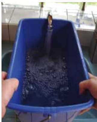
Bei nicht bestimmungsgemäßer Nutzung kann auch eine Armatur mit freiem Auslauf eine gefährdete Entnahmestelle sein
