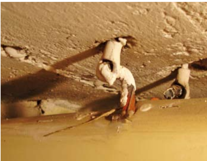
Befestigungstechnik anno 1960: Der angeschweißte Stahlstift wurde einfach in den Deckenhaken eingehängt – heute undenkbar
