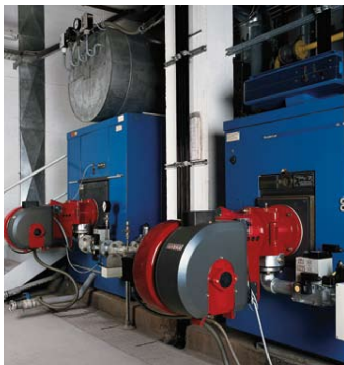
Die sichere Funktion von Gasgebläseburnern wird über die Bauteile der Gasstraße erreicht
