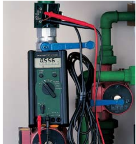
Wer mit einem Vielfachmessgerät arbeitet, muss darauf achten, dass der Messbereich richtig eingestellt ist
