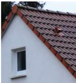
**Zugegeben: Sie sieht unauffälliger aus, hat aber Nachteile, die pilzförmige Ausmündung der Lüftung ...**
