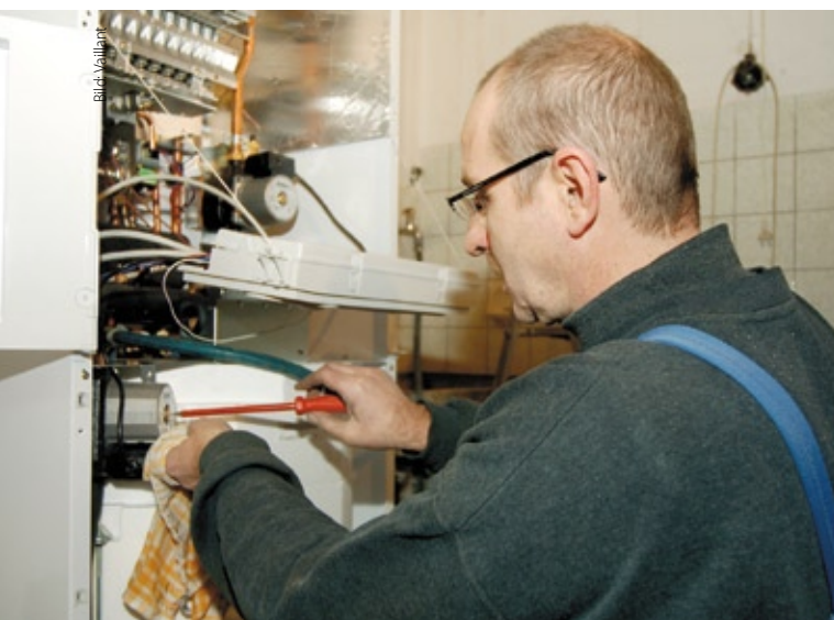
Je nach Wasserqualität muss schon die erste Befüllung der Heizung mit enthärtetem Wasser vorgenommen werden
