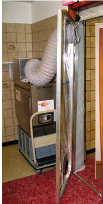
Nach nur drei Minuten Montagezeit ist die Schwingtür eingebaut und abgedichtet
