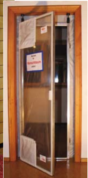
Nach nur drei Minuten Montagezeit ist die Schwingtür eingebaut und abgedichtet
