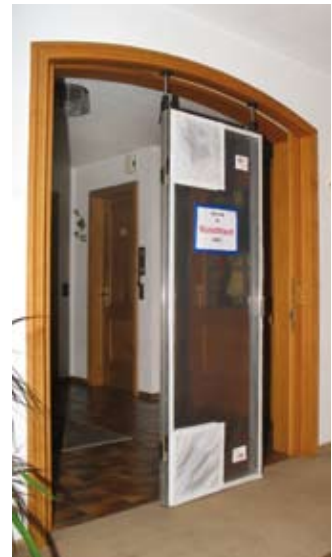
Die Schwingtür kann auch in Bogentüren eingesetzt werden; die Abdichtung ringsherum erfolgt mit Folie und Kleband
