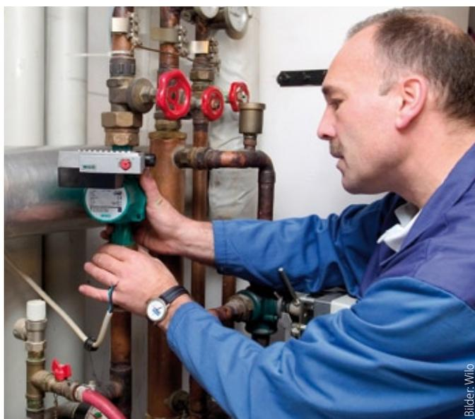
Steht die Erneuerung einer Heizungspumpe an, sollte unbedingt geprüft werden, ob die vorhandene Pumpe die richtige war
