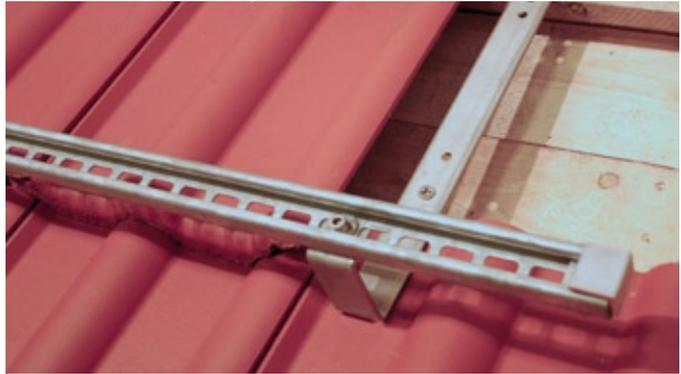
Der Dachhaken muss so angebracht werden, dass er plan auf dem Dachziegel aufliegt – sonst gibt's Bruch
