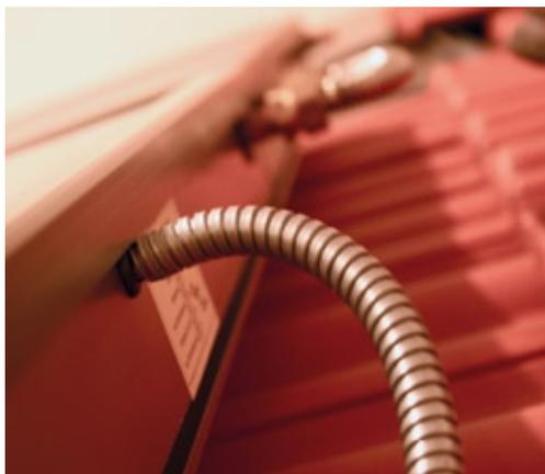
Und damit Kollege Marder nicht zum Zuge kommt, führt das Temperaturfühlerkabel durch ein Wellrohr
