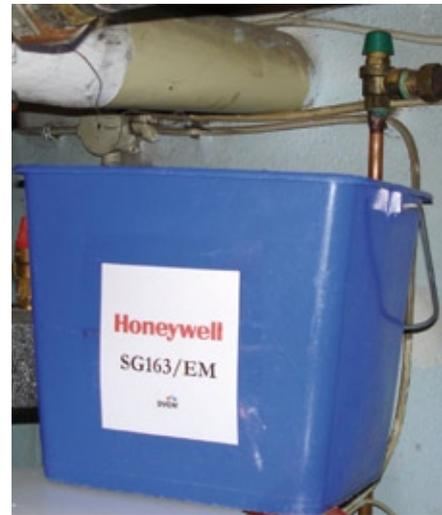
Honeywell-Sicherheitseimer SG163/EM steht dem Anwender nun ein Gefäß aus stabilem und heißwasserbeständigen PE-Xc zur Verfügung, das die Funktionskontrolle auch an diesen Sicherheitsventilen ermöglicht.
