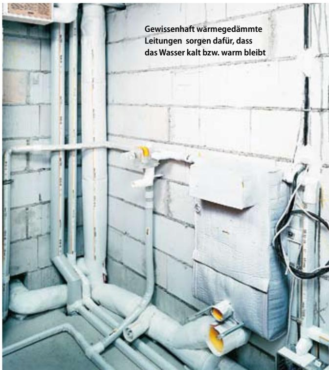
**Gewissenhaft wärmedämmte Leitungen sorgen dafür, dass das Wasser kalt bzw. warm bleibt**
