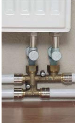
**› Heizkörperanschluss für den Altbau ◀**
